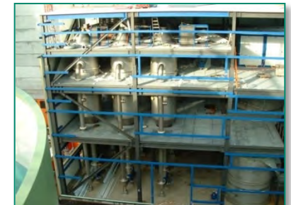
Die Anlage ist fast fertig
