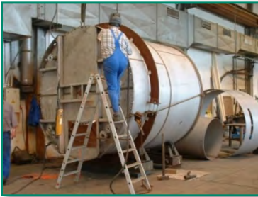
Die Behälterfertigung beginnt
