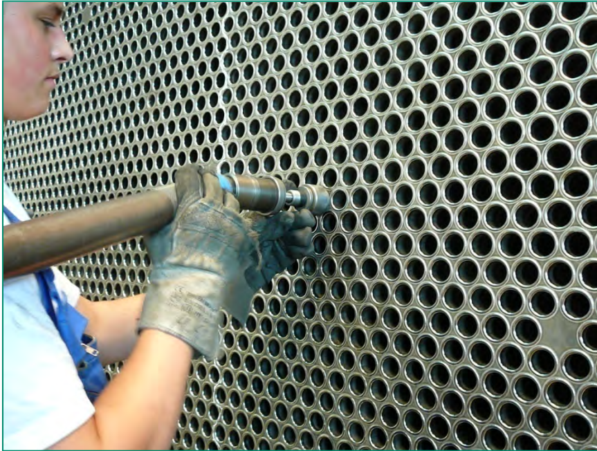
Einwalzen von Wärmetauscherrohren
