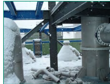
Die Bedingungen für die Montage werden schwieriger. Es wird frostiger
