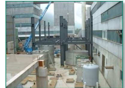
Die Stahlgerüste wachsen
