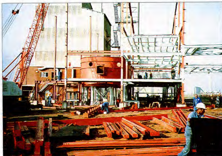
Errichtung der Salzgewinnungsanlage / Монтаж установки для извлечения соли.
