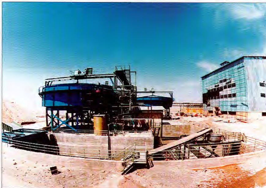
Salzgewinnungsanlage nach Fertigstellung / Установка для извлечения соли.
