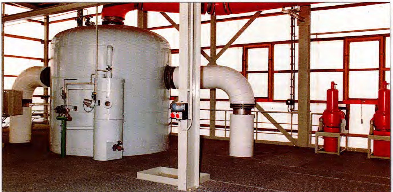
Umlaufverdampfer mit mehreren außenliegenden Heizkörpern / Циркуляционный выпариватель с несколькими наружными радиаторами.
