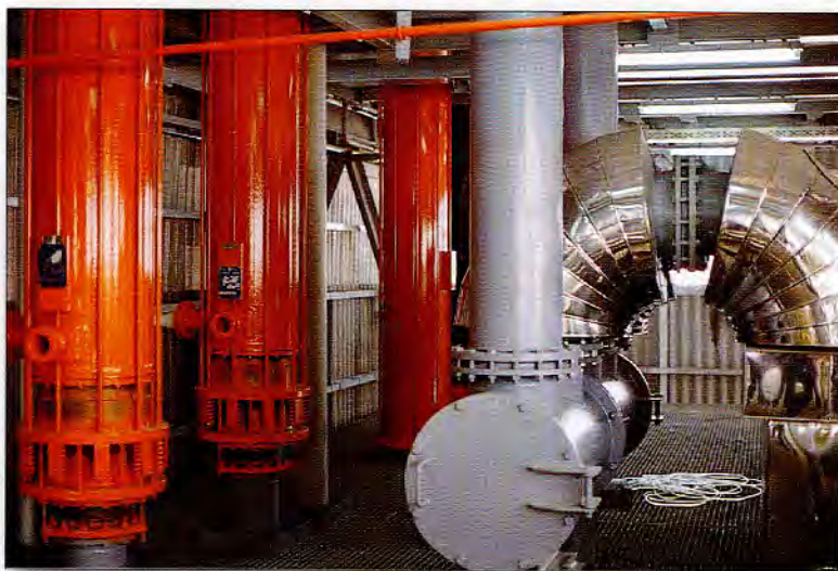
Absorptionsanlage für \text{HCl} / Абсорбционная установка для \text{HCl}
