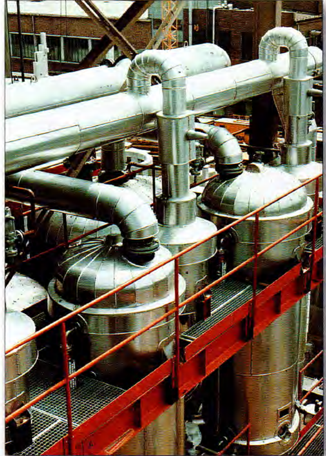
Kristallisationsanlage für Glaubersalz mit NH 3 -Kühlung / Установка для кристаллизации Глауберовой соли с охлаждением
