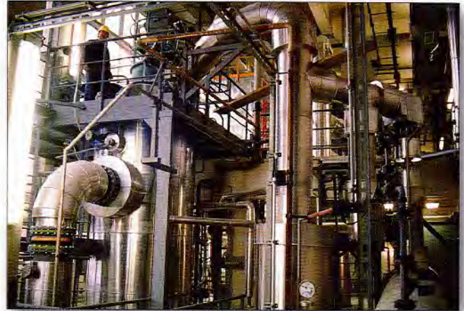
Teilansicht einer Abwasseraufbereitungsanlage für Abwasser einer Rauchgasentschwefelungsanlage nach „Walther-Verfahren“ / Подпись к рисунку: Поперечное сечение установки для регенерации сточных вод при обессеривании топочных газов, работающая на основе «Вальтерпроцесс».
