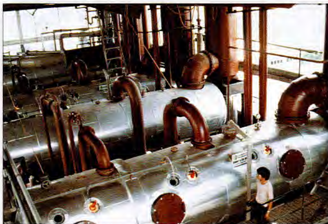
Mehrstufige Eindampfanlage mit liegenden Verdampfern /
