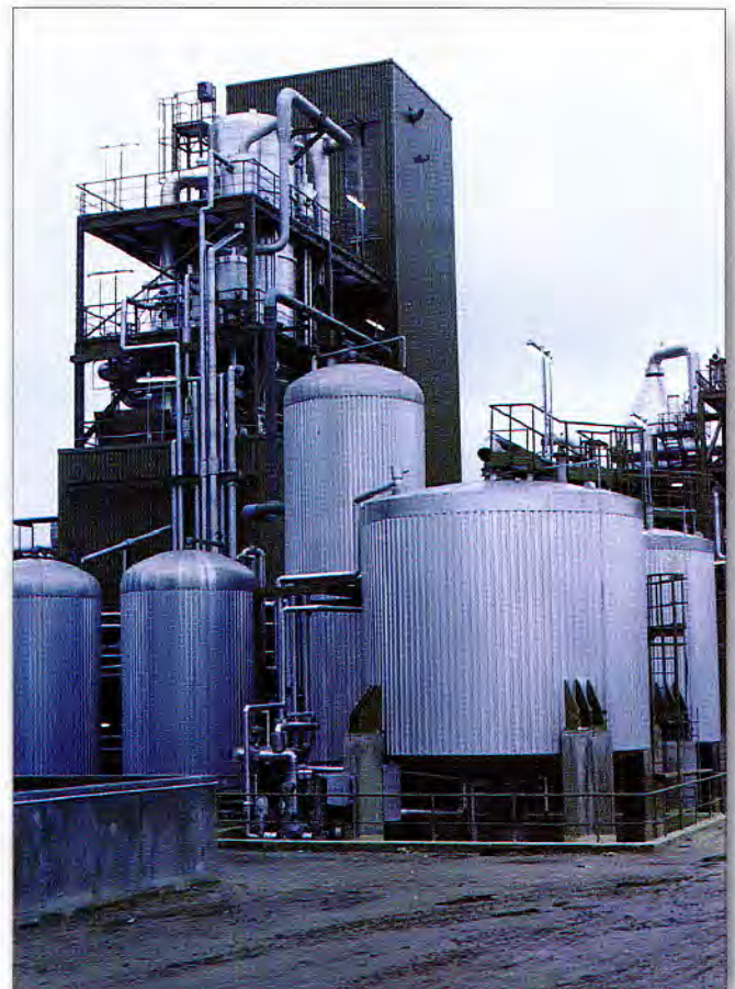
Vorlagebehälter und Teilansicht einer Anlage für Salzrecycling aus Prozessabwässern / хранилище и частичный вид установки для извлечения соли из сточных вод.
