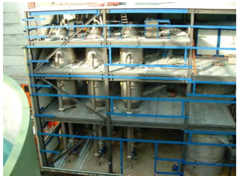
Die Anlage ist fast fertig The plant is nearly finished
