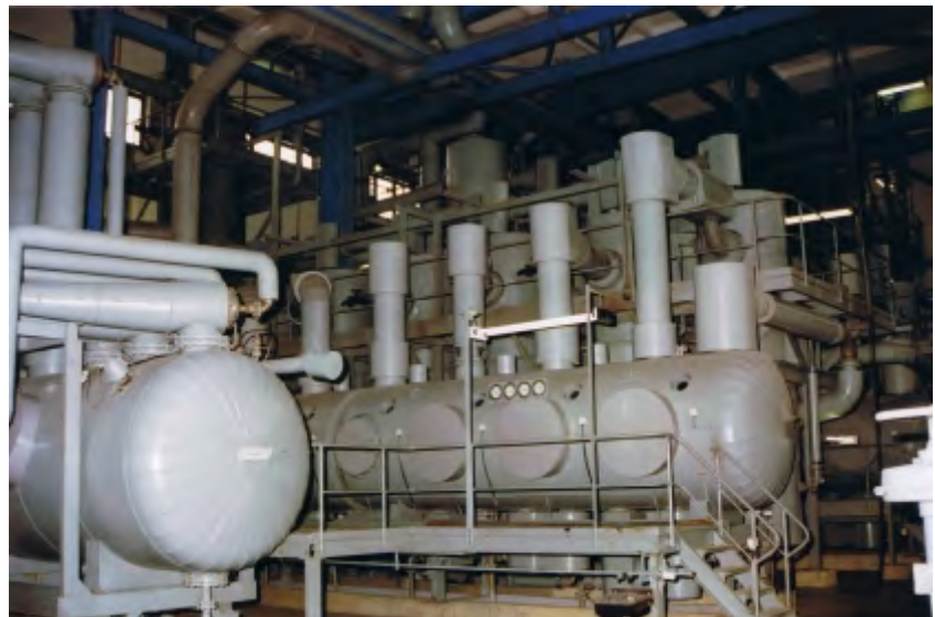
11-stufige Entspannungsverdampfungsanlage 11-stage flash evaporation plant
