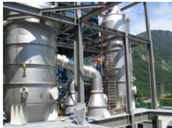
Schmelzkristallisator, ausgeführt als Verdampfungskristallisator Melting crystallizer designed as evaporation crystallizer
