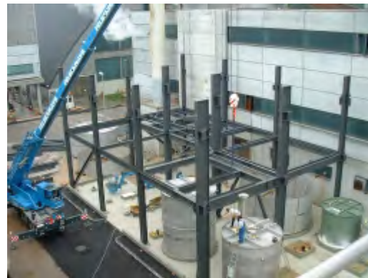
Die Stahlgerüste wachsen Growth of the steel structure
