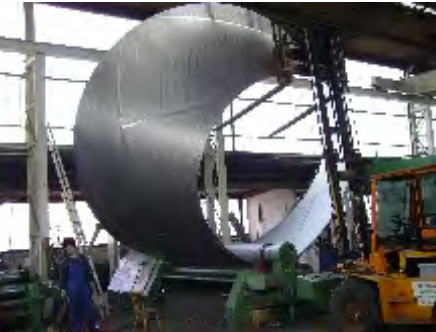
Die Behälterfertigung beginnt Start of vessel fabrication
