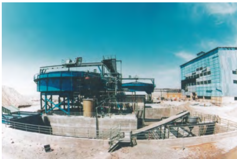
Salzgewinnungsanlage nach Fertigstellung Salt recovery plant after installation
