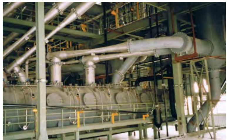
An einem Vakuumkühl- kristallisator installierte Dampfstrahlapparate Steam ejectors installed at a vacuum cooling crystallizer
