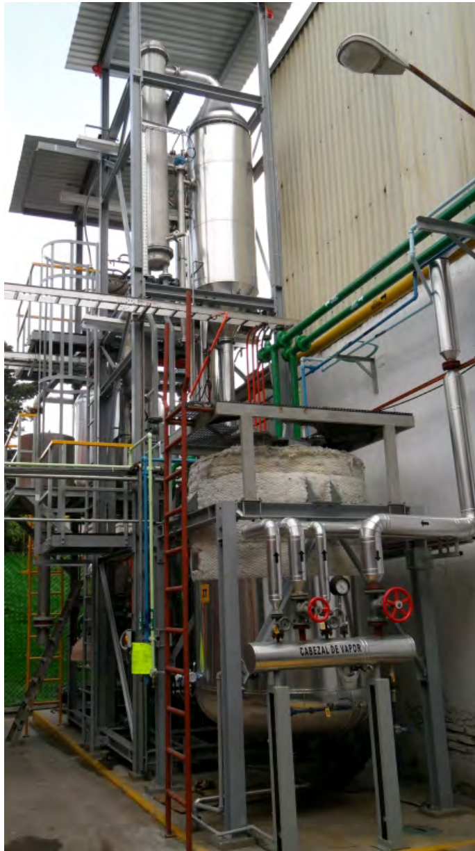
Pilotanlage zur Kristallisation von Bernsteinsäure Pilot plant for crystallization of succinic acid
