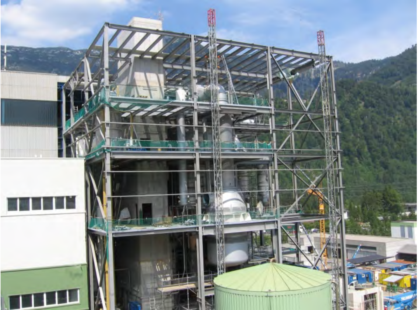
Anlage während der Montage Plant during erection
