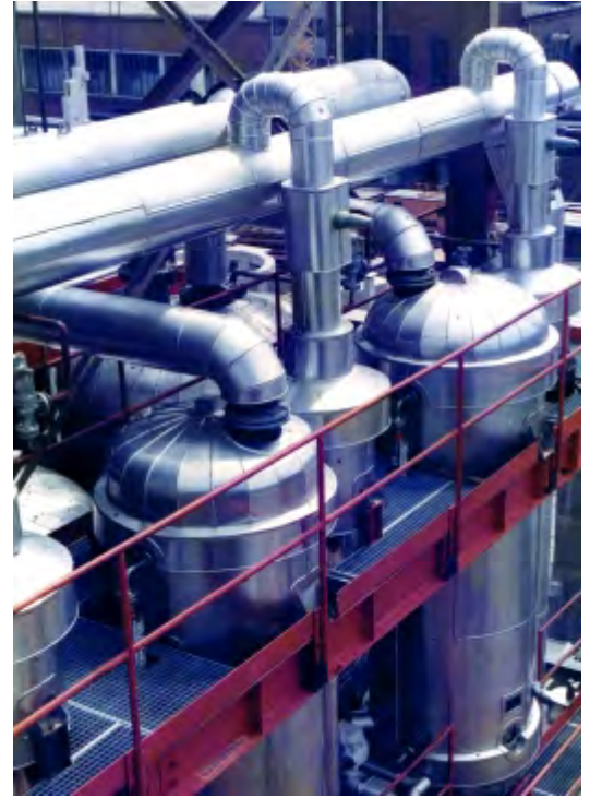
Kristallisationsanlage für Glaubersalz mit NH_3 -Kühlung Crystallization plant for glauber's salt with NH_3 -cooling
