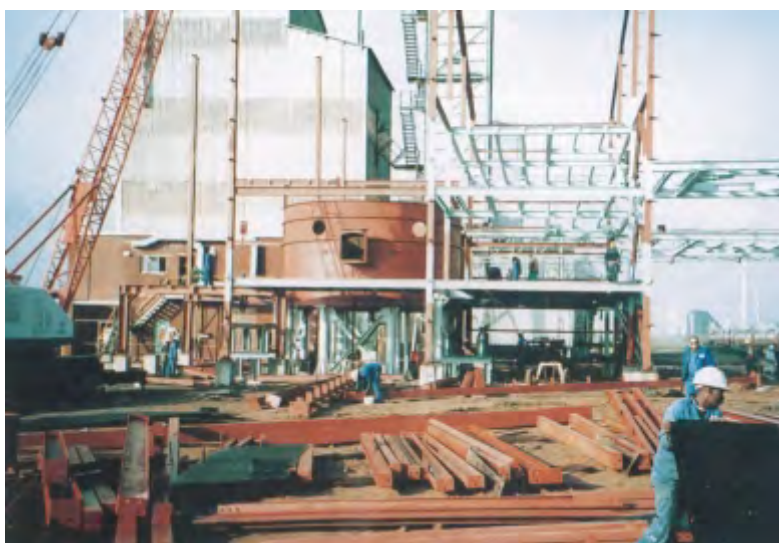
Errichten der Salzgewinnungsanlage Erection of the salt recovery plant
