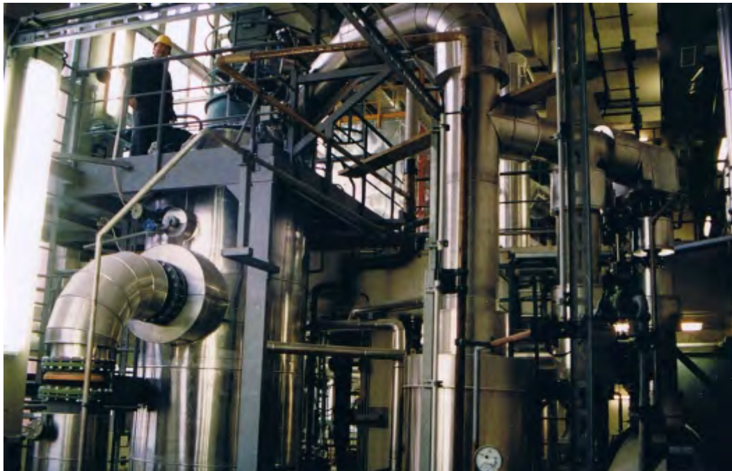
Teilansicht einer Abwasseraufbereitungsanlage für Abwässer einer Rauchgasentschwefelung Section view of a waste water regeneration plant for waste waters of a flue gas desulphurization
