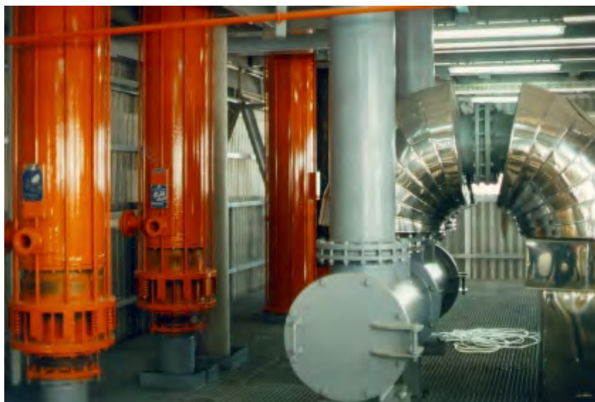
Absorptionsanlage für HCl / Absorption plant for HCl
