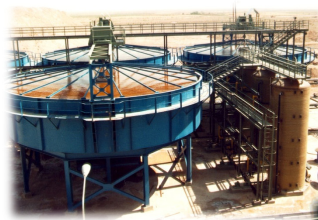
Станция растворения шлама
