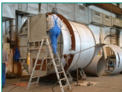
Начало изготовления баков
