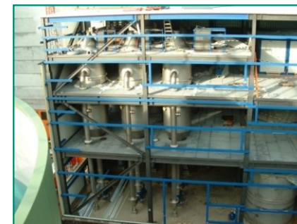
Установка почти готова
