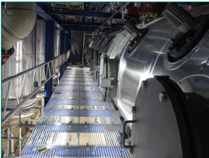
Раширительная выпарная установка
