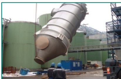
Основные компоненты системы устанавливаются в установку
