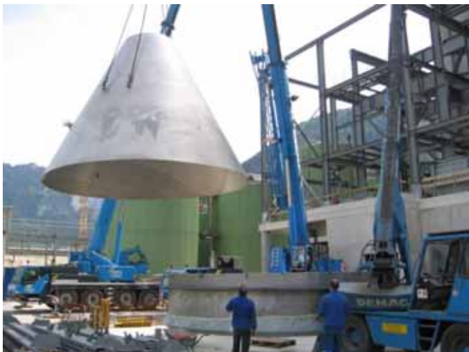
Baustellenfertigung und Montage (Österreich) Verdampfungskristallisator Ø 6.400 mm, Gesamtlänge 18.700 mm, 56 t, 1.4562
