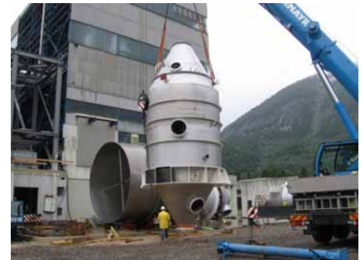
Baustellenfertigung und Montage (Österreich) Verdampfungskristallisator Ø 6.400 mm, Gesamtlänge 18.700 mm, 56 t, 1.4562
