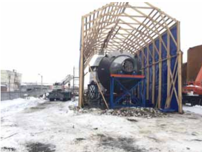
Baustellenfertigung und Montage (Russland) Verdampfungskristallisator Ø 5.400 mm, Gesamtlänge 21.800 mm, 40 t, 1.4562
