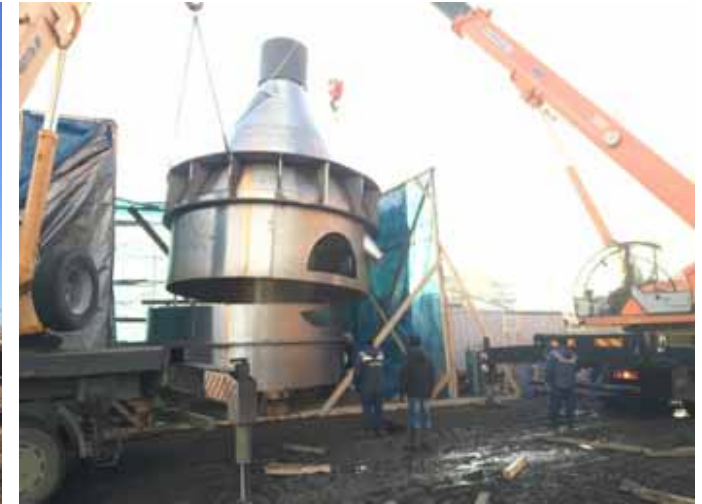
Baustellenfertigung und Montage (Russland) Verdampfungskristallisator Ø 5.400 mm, Gesamtlänge 21.800 mm, 40 t, 1.4562
