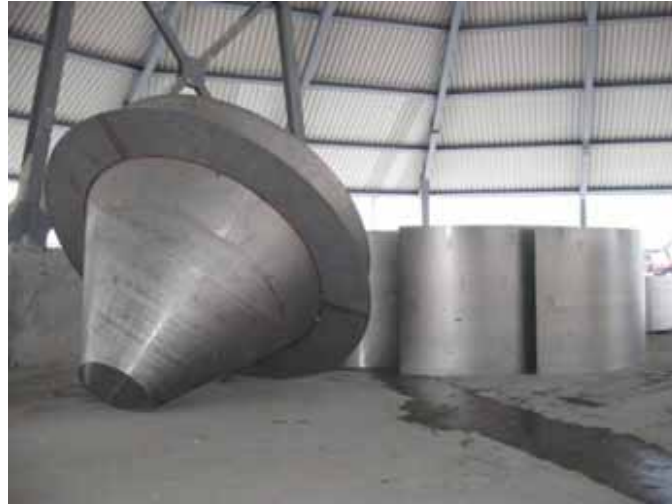
Baustellenfertigung und Montage (Österreich) Verdampfungskristallisator Ø 6.400 mm, Gesamtlänge 18.700 mm, 56 t, 1.4562
