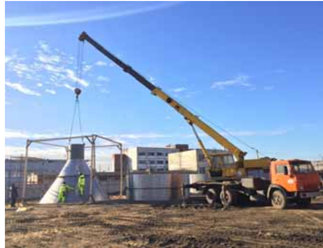
Baustellenfertigung und Montage (Russland) Verdampfungskristallisator Ø 5.400 mm, Gesamtlänge 21.800 mm, 40 t, 1.4562
