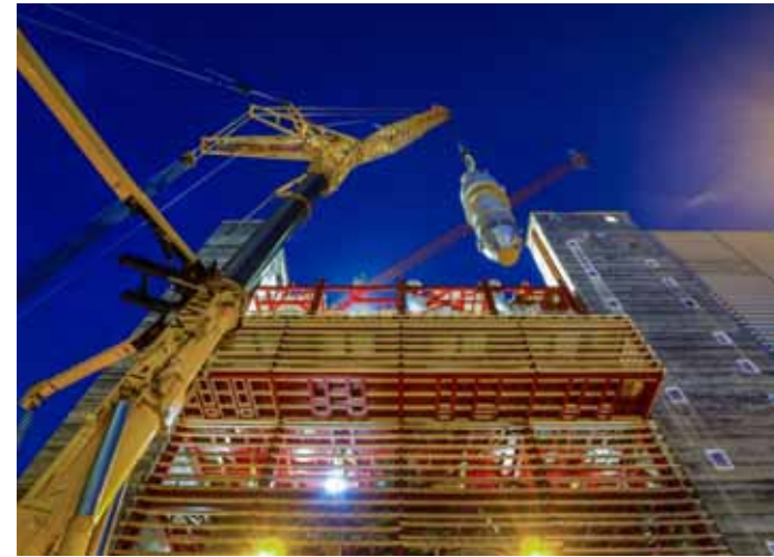
Wärmeaustauscher Ø 3.100 mm, Gesamtlänge 17.640 mm, Gewicht 113 t Ein Spezialtransport auf Luftkissen war notwendig
