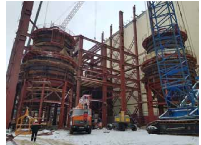
Baustellenfertigung und Montage der 7-stufigen Vakuumkristallisation (Weißrussland)
