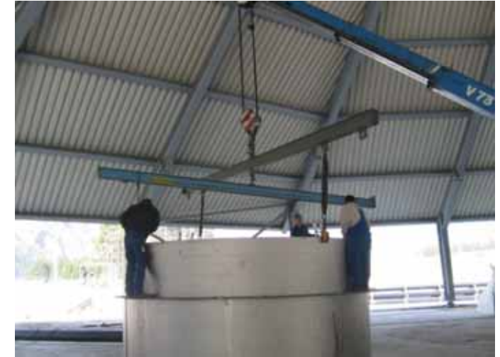
Baustellenfertigung und Montage (Österreich) Verdampfungskristallisator Ø 6.400 mm, Gesamtlänge 18.700 mm, 56 t, 1.4562
