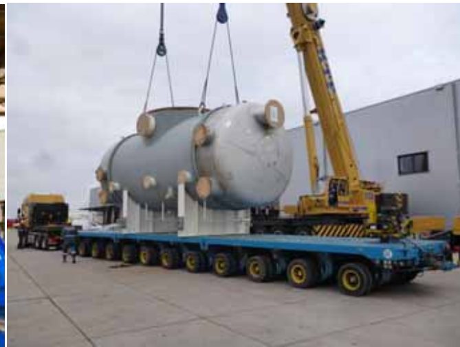
Fertigung und Montage (Niederlande) Seewasserkondensator Ø 3.650 mm, Gesamtlänge 10.000 mm, 40 t, 1.4462/P355GH
