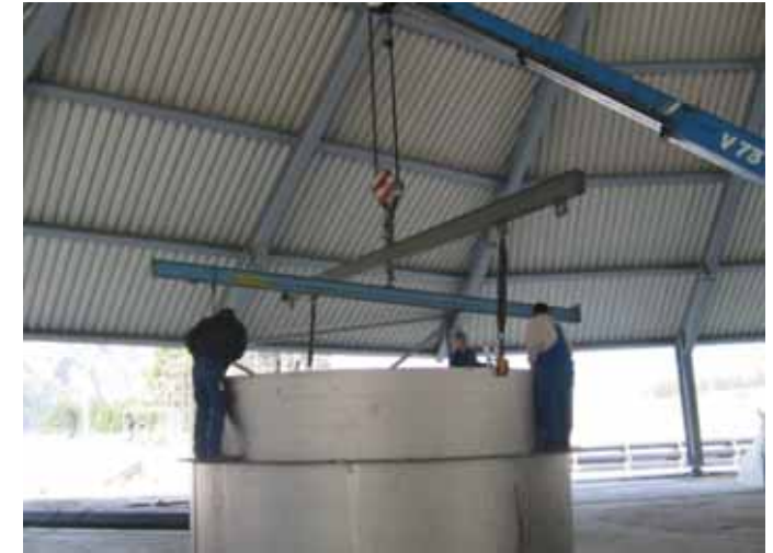
Сборка на строительной площадке и монтаж (Австрия) Выпарной кристаллизатор Ø 6.400 мм, общая длина 18.700 мм, 56 т, 1.4562
