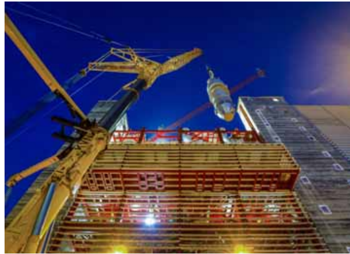
Теплообменники Ø 3.100 мм, общая длина 17.640 мм, вес 113 т Транспорт при помощи специального транспорта на воздушных подушках
