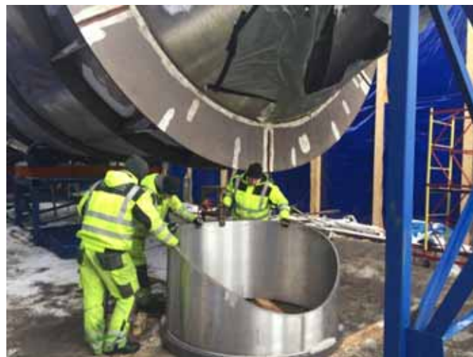
Сборка на строительной площадке и монтаж (Россия) Выпарной кристаллизатор Ø 5.400 мм, общая длина 21.800 мм, 40 т, 1.4562
