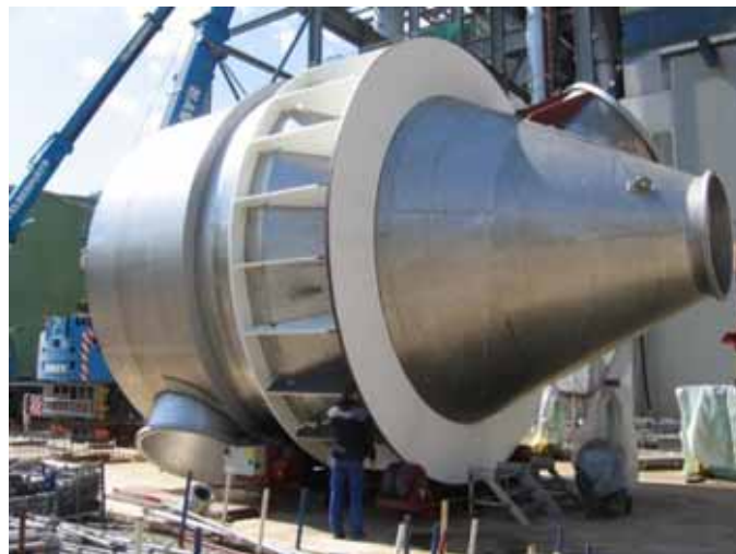
Сборка на строительной площадке и монтаж (Австрия) Выпарной кристаллизатор Ø 6.400 мм, общая длина 18.700 мм, 56 т, 1.4562
