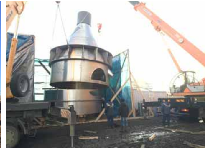
Сборка на строительной площадке и монтаж (Россия) Выпарной кристаллизатор Ø 5.400 мм, общая длина 21.800 мм, 40 т, 1.4562
