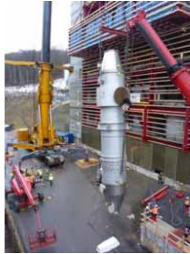
Теплообменники Ø 3.100 мм, общая длина 17.640 мм, вес 113 т Транспорт при помощи специального транспорта на воздушных подушках
