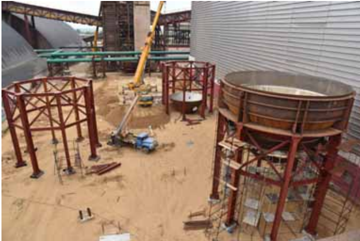
Производство и монтаж 7-ступенчатой системы вакуумной кристаллизации на строительной площадке (Беларусь)
