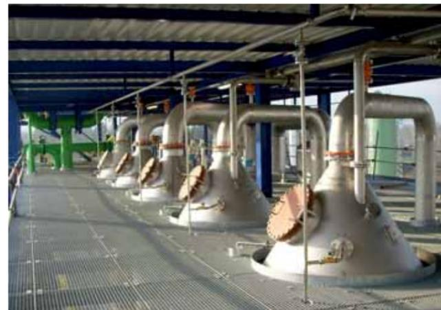
Verdampfungskristallisatoren mit Brüdenabzug
