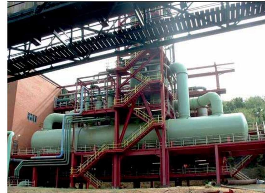
Vakuumkühlkristallisationsanlage zur Erzeugung von  $\text{MgSO}_4 \times 7\text{H}_2\text{O}$
