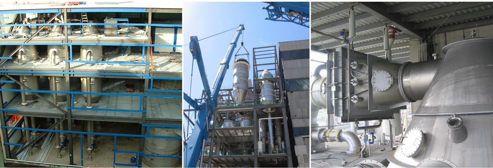
EBNER plante, lieferte und montierte bei einer Saline eine Anlage zur Erzeugung von Natriumchlorid durch eine kombinierte Schaltung von Verdampfungs- und Kühlkristallisation.
